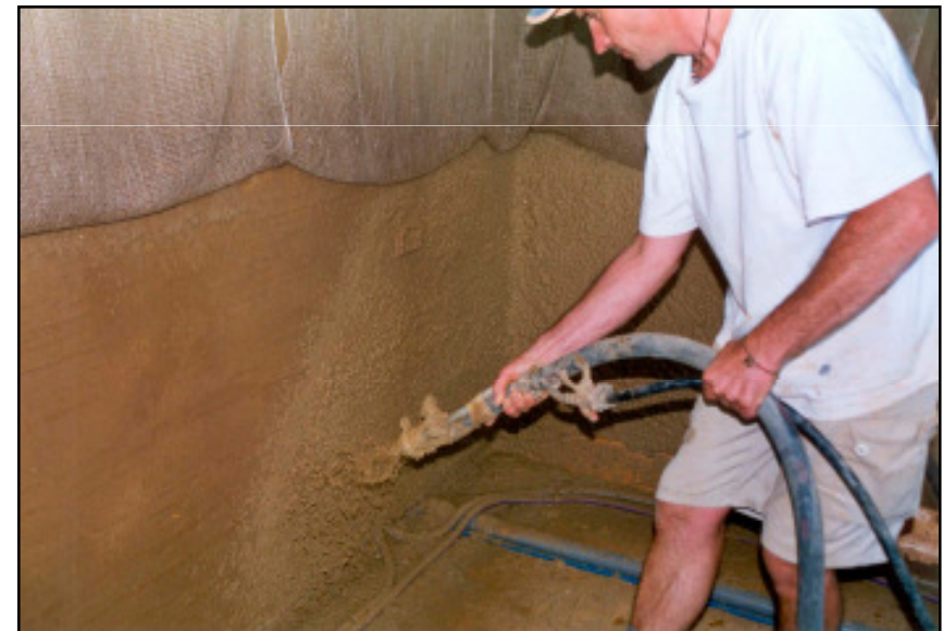
Die Wände Innen – Lehmputz Le pareti all'interno – intonaco a base di terra argillosa
